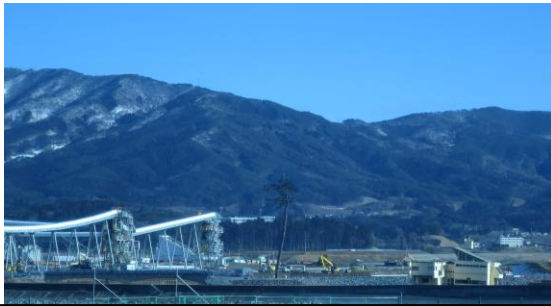
③「奇跡の一本松」（岩手県陸前高田市）。周囲にはかさ上げの為にベルトコンベアが多く設置されていた。
