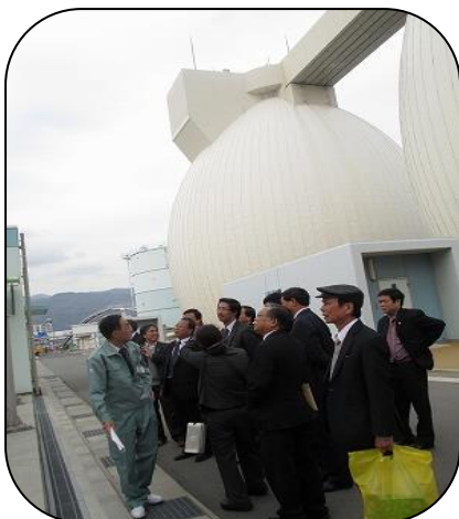
東灘下水処理場の視察
